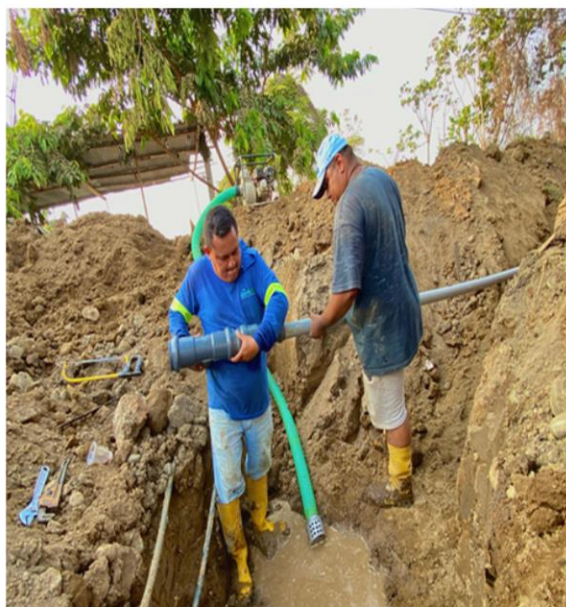
Ampliación de redes AAPP
